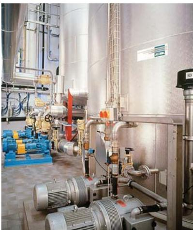
ALPHA-BIOTHERM<sup>®</sup> sludge pasteurisation plant
